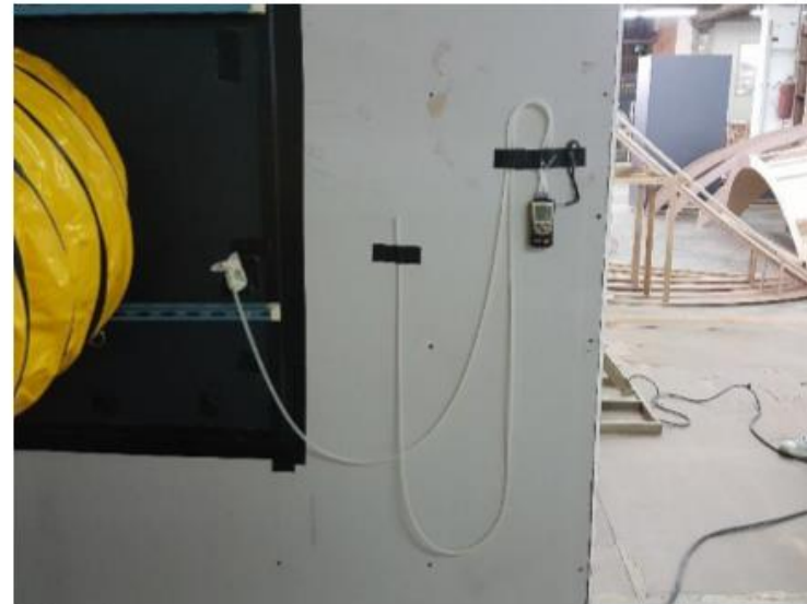
การติดตั้งเครื่องวัดความดันอากาศแตกต่าง (Digital Manometer)
