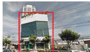
4. อาคารสำนักงาน (บีอาร์ไอ) สูง 36 เมตร
