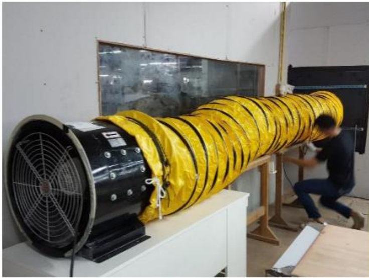
พัดลม Blower ขนาด 6,500 CFM เชื่อมต่อสู่ห้องโดยท่ออลม
